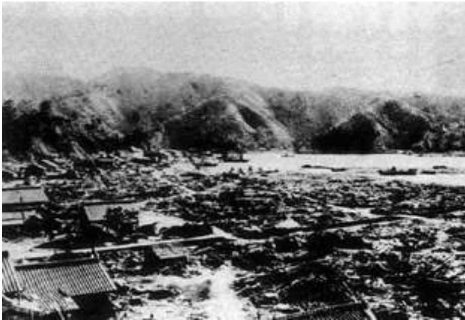
錦地区の津波被害状況（『くろしお 錦小学校創立百周年記念』より）
