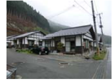
岩手県住田町営住宅 木造1戸建て
