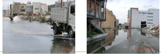
1mの地盤沈下で今でも満潮時に冠水
