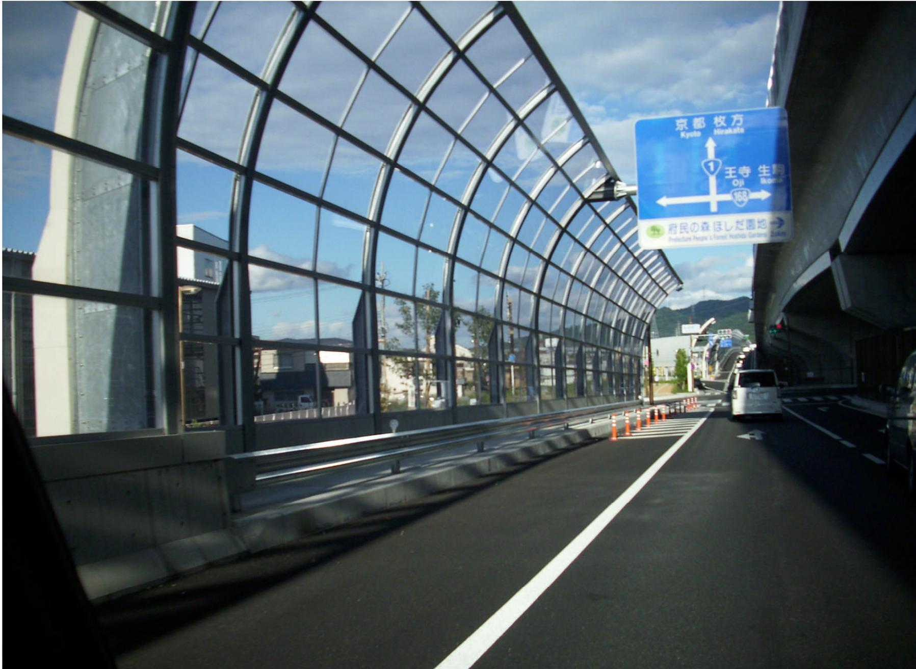
交野・枚方(ただし、津田南迄) に設置された裏面吸音板
