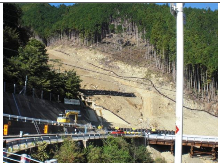
大滝ダム周囲の森林崩壊現場→ダムに多量の土砂→洪水の危険
