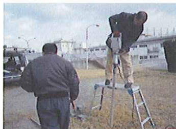
ボーリング調査 2015.2.12
