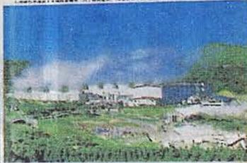
熱水を低温高圧液体と熱交換し、この高圧でタービンを回す「バイナリーサイクル方式」が開発されている。1925年 初回で1.12KW 1966年 岩手県松川発電所営業運転 現在 18ヵ所（家庭用13ヵ所・自家用5ヵ所）※東北電力遠田発電所で三酸マテリアルが新に開発 課題：熱資源の80%が国立公園内に 地元温泉との相互理解 世界トップクラスの技術輸出を
