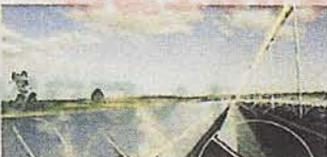
地面に置かれた多数の鏡で、上方にあるパイプに集光して加熱することで蒸気を発生。熱もまた熱の必要がないのがメリット。
