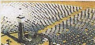
平面上の鏡を多数用いて、タワー上部に置かれる集熱器に光を当てます。太陽の動きを追尾する水筒が熱源になります。
