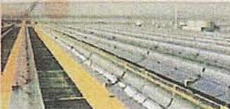
曲面鏡を利用してパイプに太陽光を集中させることで400℃近くまで加熱。パイプ内の液体を高温に熱してタービンを回し発電します。
