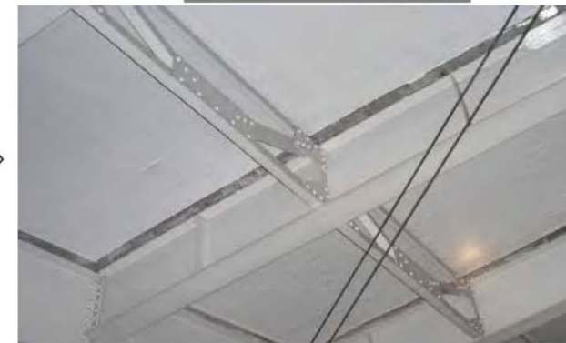
補修後の状況
