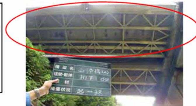
桁下の状況(P1-P2)
