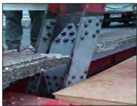
補修後の状況
