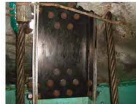
破断箇所の応急復旧状況
