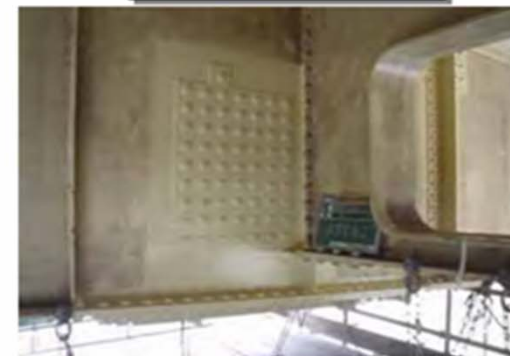
あて板による応急対策
