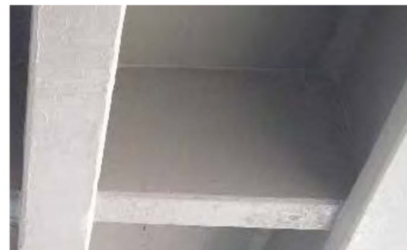
補修後の状況
