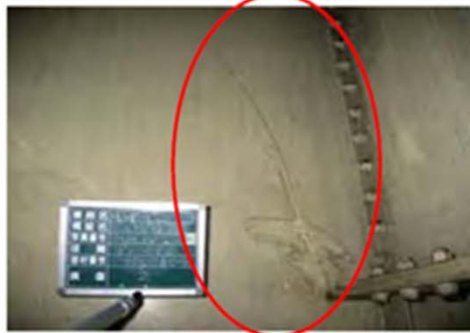
P1-P2径間の主桁の横桁取り付け部付近の長さL=1.1mの亀裂
