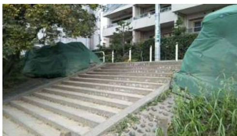
多摩川左岸 二子玉川駅上流部 中) 大型土嚢が仮置きされている 右) 地下階クリニックの被災
