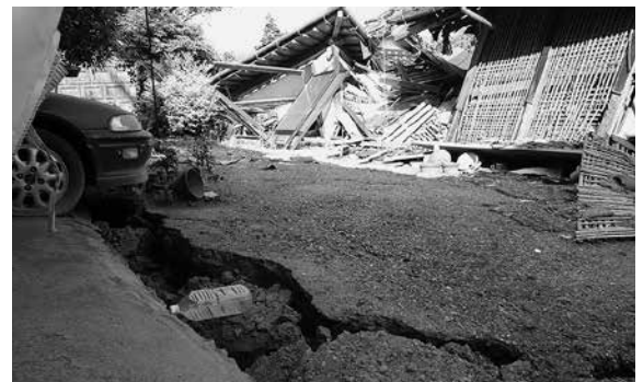
開口亀裂が傾斜敷地の頭部で発達、敷地は傾斜方向にずり下がるように変状
