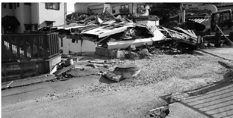
道路は亀裂や陥没で波打ち、マンホールが浮き上がる地盤変状が顕著
