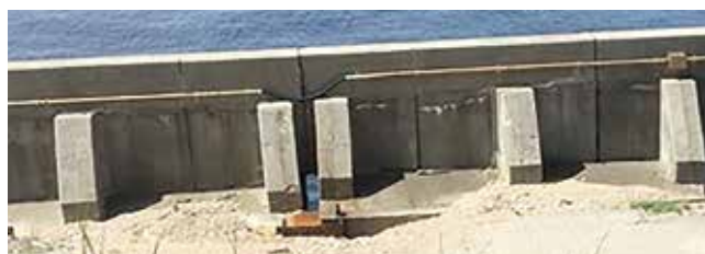
大阪市長自慢の防波堤、津波をまともに受ける南側には亀裂が走る！
