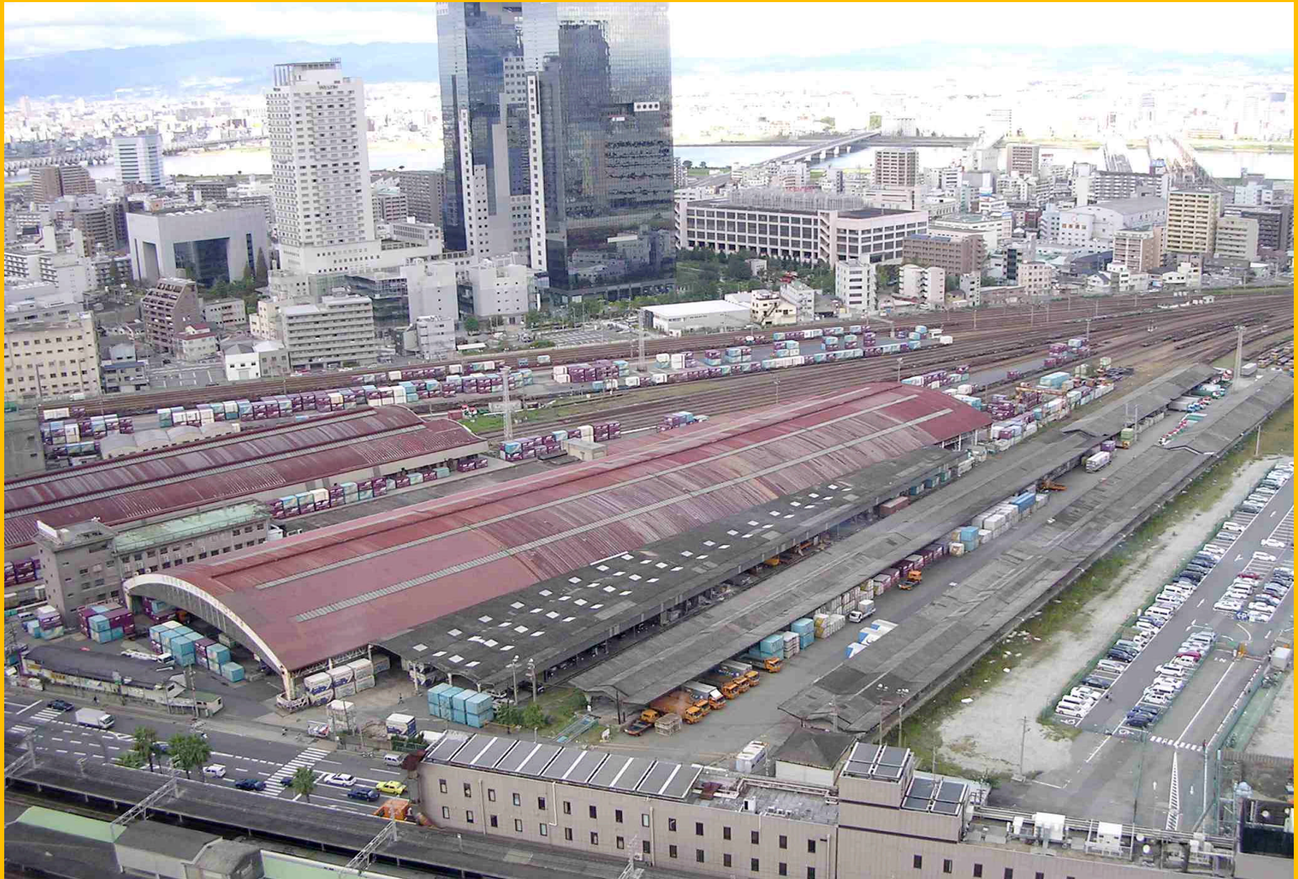
移転工事前の梅田貨物駅(大阪駅北ヤード)
