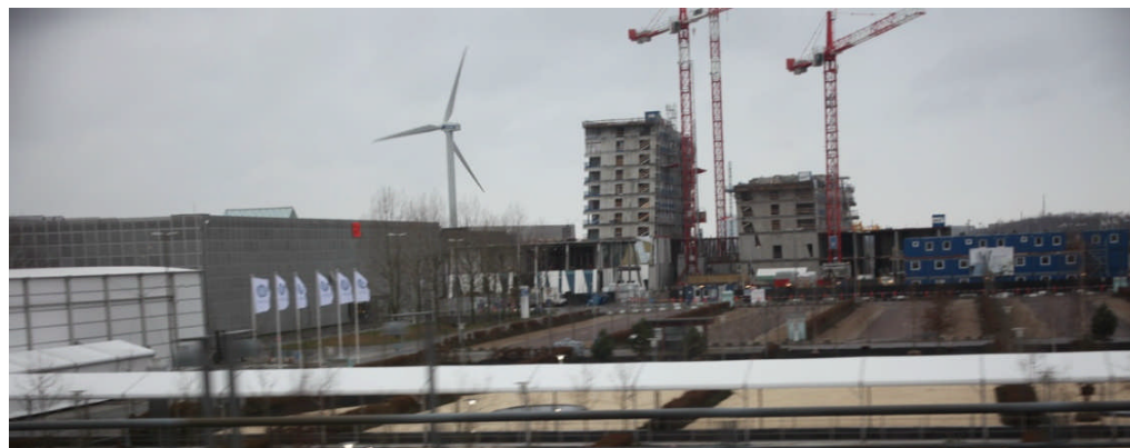
COP15の会場(左側)。まだ工事中のところも。
